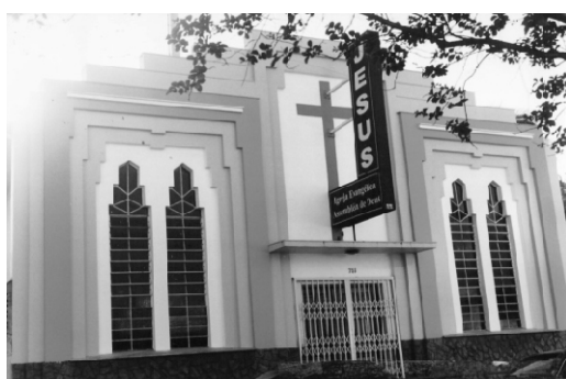
Fig. 9: Templo da Assembléia de Deus na Rua Bento Gonçalves, São Leopoldo
